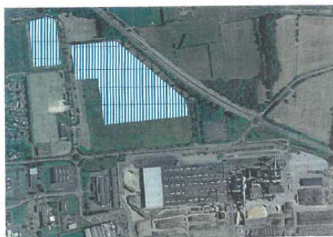
ZAE de Bazeilles – 10 000 MWh
