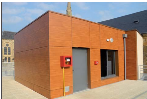
Chaufferie sur la terrasse du 1 er étage.
