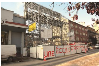
Chantier de l'Esnam, avenue Jean-Jaurès à Charleville-Mézières
