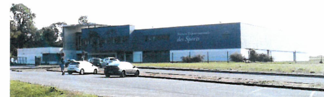
Maison des sports départementale
