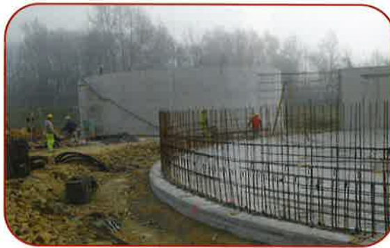
Etat d'avancement des travaux
