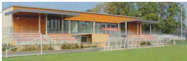
2006 l'ensemble vestiaires, clubhouse, tribunes réalisé par la municipalité
