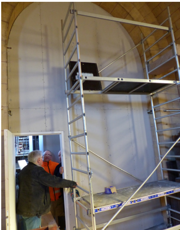
Mise en place de la nouvelle cloison
