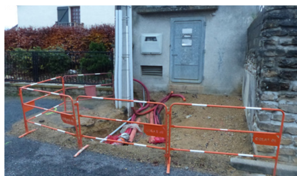
Le début des travaux rue Carville et rue Mayot
