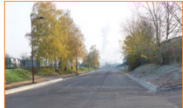
Vue depuis l'autre entrée de la rue : la voie très élargie avec la bande de stationnement de 400 m située sur partie droite
