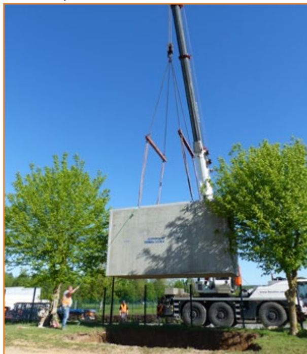
Installation de la cuve pour l'arrosage du stade
