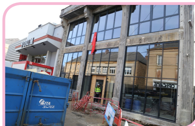
Le principal défi de ce chantier : conserver coûte que coûte l'ancienne façade des magasins Troussel
