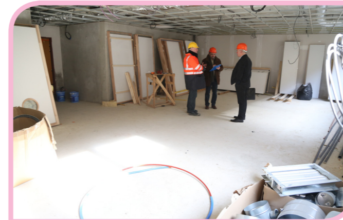
Le gros œuvre terminé, les ouvriers s'occupent désormais des aménagements intérieurs
